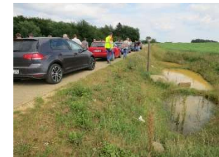
Wegseitengraben mit Regenrückhaltebecken
