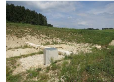
Sammelbecken; dient der Vermeidung von Überschwemmungen
